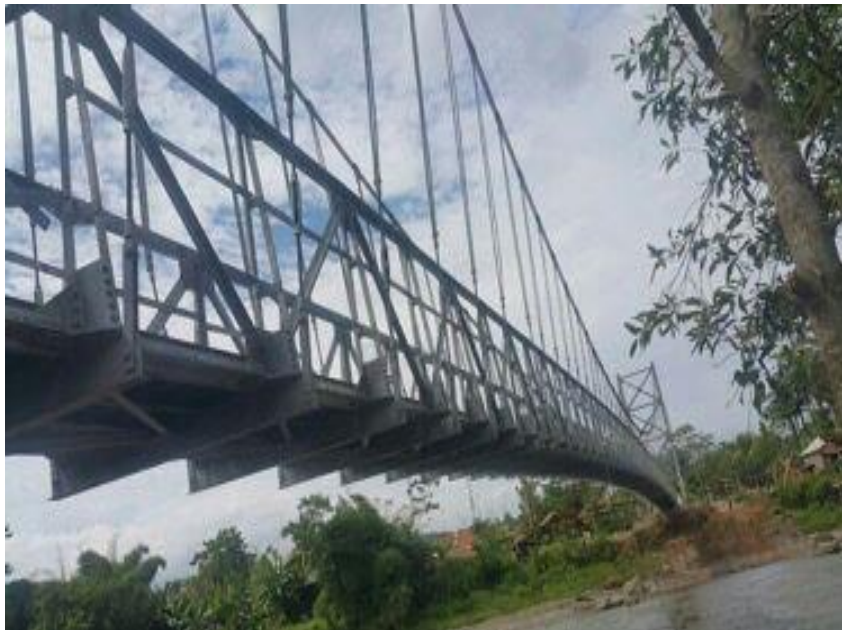
Jembatan Gantung Kali Cipamingkis, Jabar
