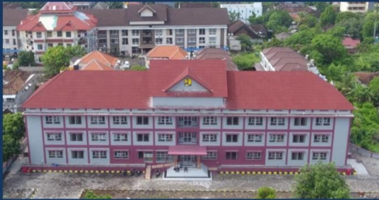
• Tampak Depan Rusun (drone)
